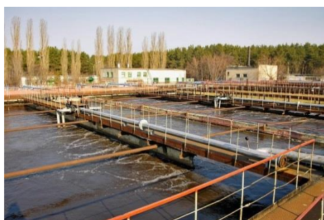
Очистные сооружения МУП «Аквасервис» г. Нововоронеж
