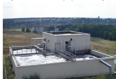
Очистные сооружения ООО «Острогжский завод по производству солода»
