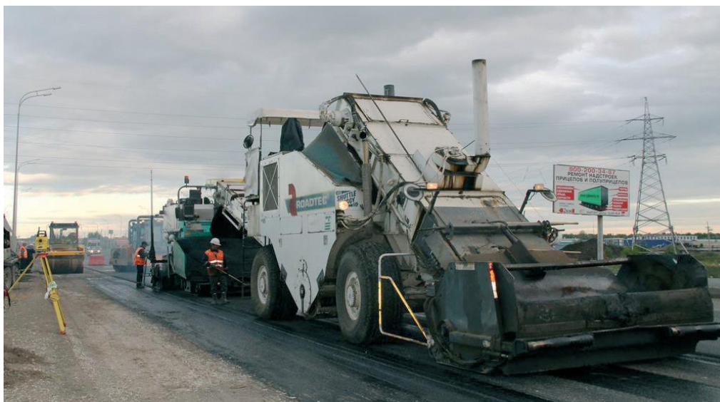
Рисунок 2. Реконструкция автомобильной дороги федерального значения М7 «Волга»
