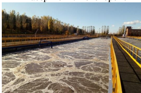
Канал аэротенка Правобережных очистных сооружений г. Воронежа
