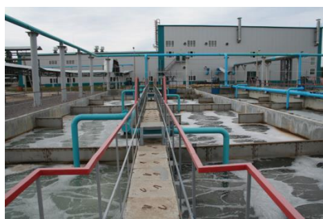
Очистные сооружения ОАО «Воронежсинтезкаучук», г. Воронеж
